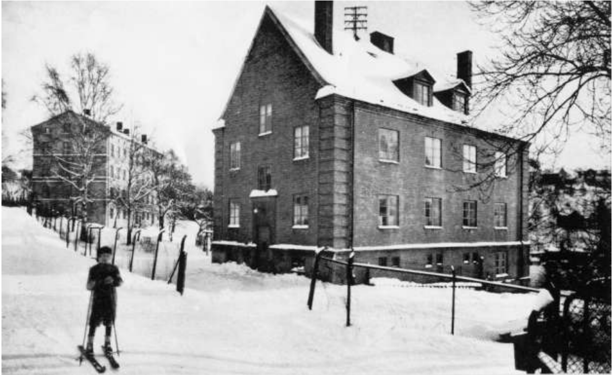
Havehuset i 1930-årene. Murgården i balgrunnen
